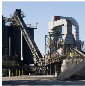
压缩空气、大口径送风监
